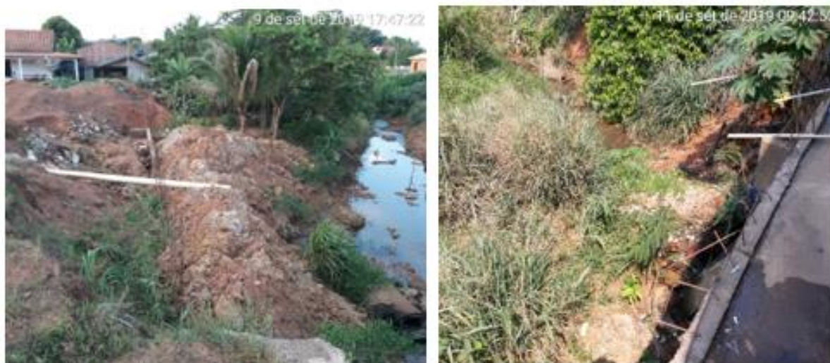
Figura 163 – Lançamento de esgotos em canal de drenagem natural – distrito de Migrantinópolis
