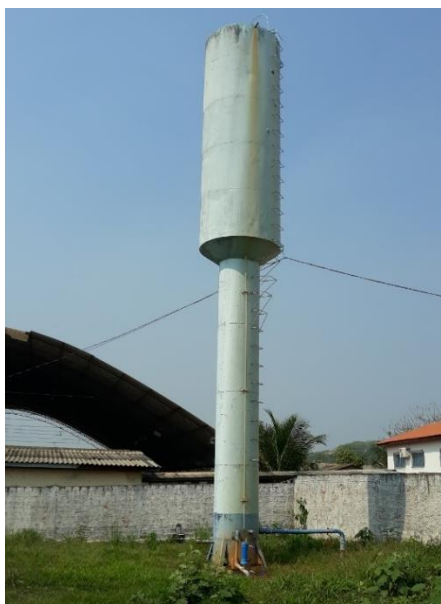
Figura 104 - Reservatório de Abastecimento Migrantinópolis.
