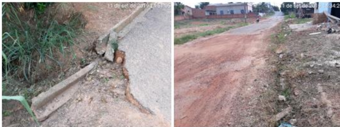
Figura 154 - Condição de manutenção de meio fios e sarjetas
