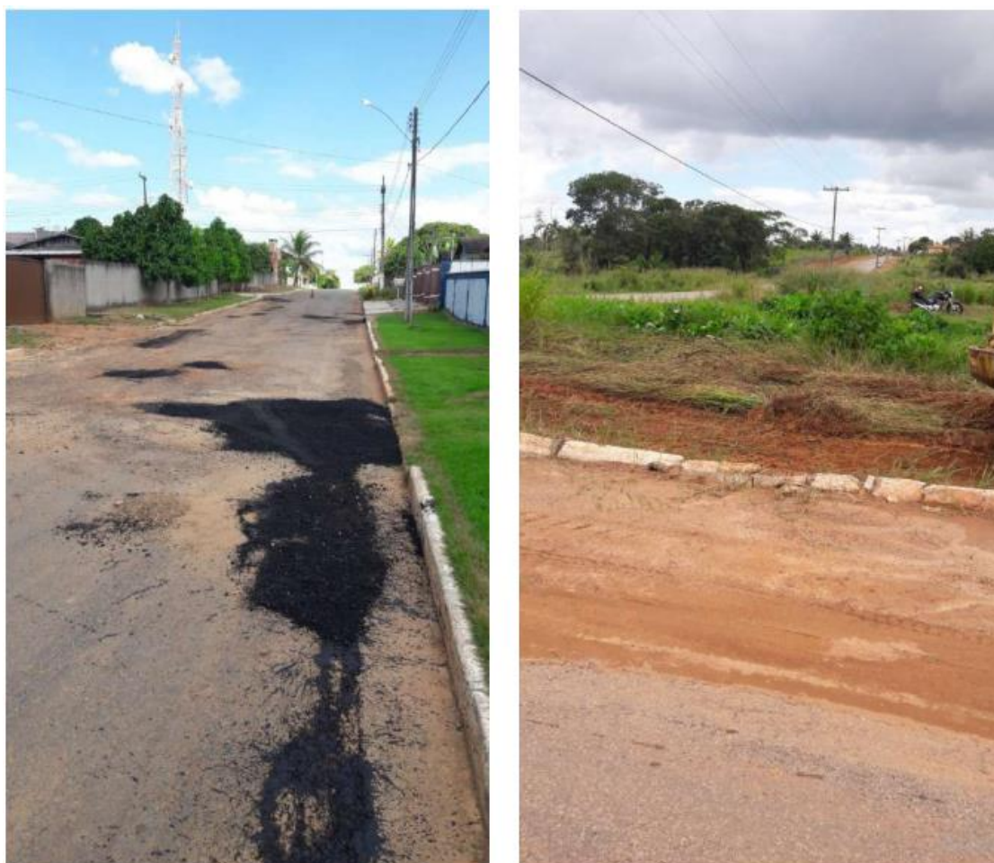
Figura 55 – Aplicação de microrrevestimento a frio em ruas e avenidas na sede e no Distrito de Migrantinópolis.
