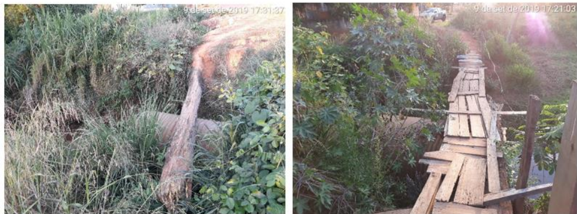
Figura 172 – Passarelas rudimentares para pedestre em locais onde houve o arraste do aterro
