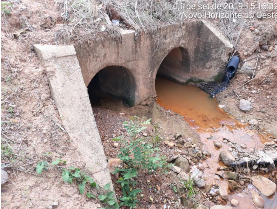
Figura 158 - Lançamento de esgotos em canal de drenagem natural – Rua Perobão – sede
