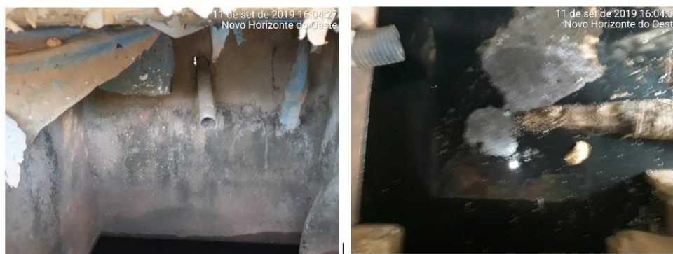
Figura 120 – Lançamento e esgotos em drenagem na Av. Dr. Miguel Vieira Ferreira
