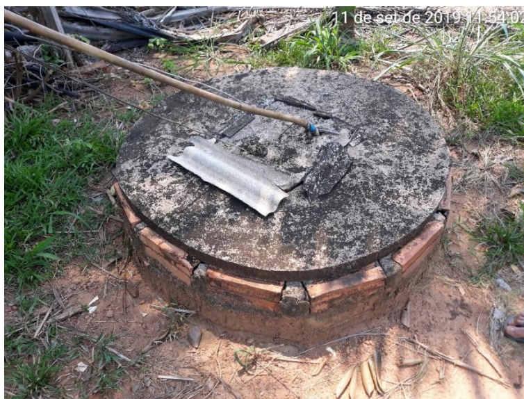
Figura 106 – Poço Amazonas em localidade não atendida pelo Sistema de Abastecimento - Migrantinópolis
