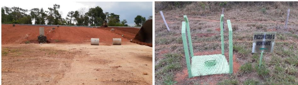
Figura 181 – Esquerda: Sistema de drenagem do e de gases da célula. Direita: Piezômetro
