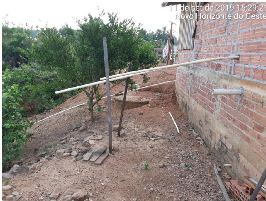
Figura 160 - Lançamento de esgotos de pia e chuveiro em canal de drenagem natural
