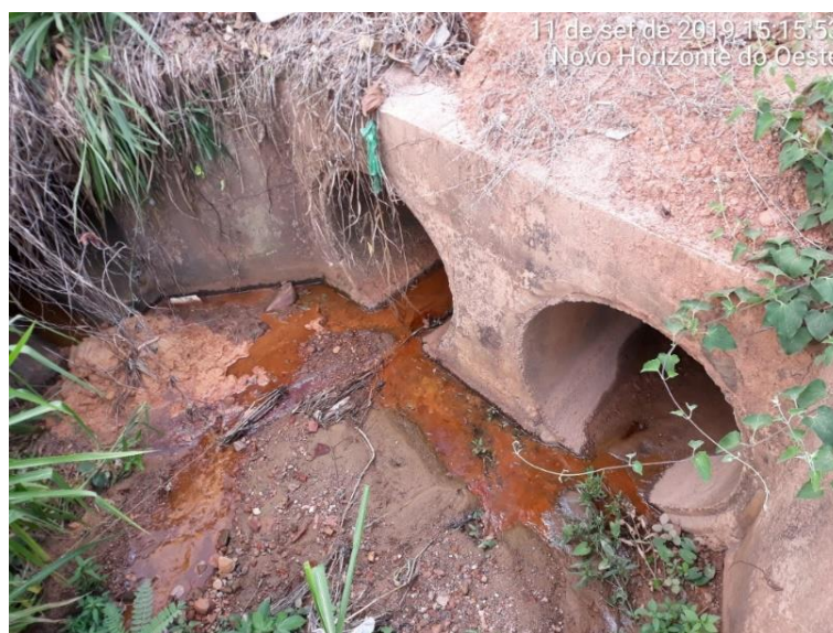
Figura 140 - Galeria – canalizador principal da macrodrenagem da sede, situado na Av. Perobão
