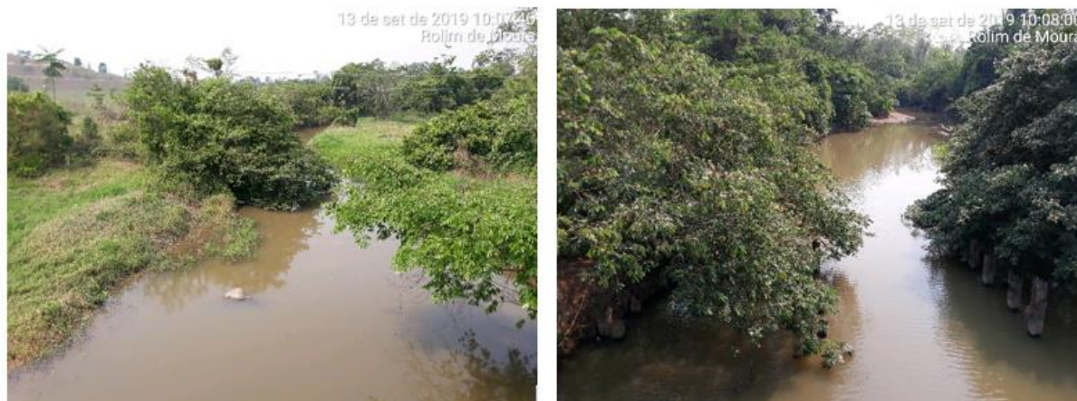
Figura 109 - Rio Palha no cruzamento com RO-010: Esquerda Montante e Direita Jusante
