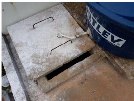
Figura 77– Caixa de preparo e dosagem do cloro no reservatório
