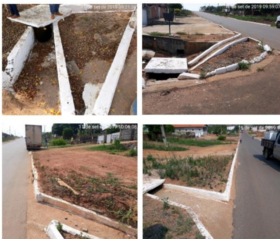
Figura 146 – Infraestrutura de drenagem na Rodovia RO – 010 – Meio fio, sarjeta e boca de lobo (Distrito de Migrantinópolis)
