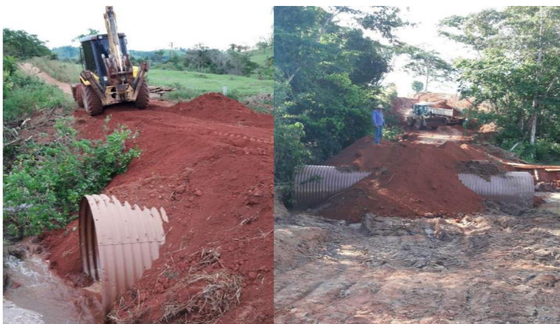
Figura 54 – Instalação de tubos metálicos na área rural do município.
