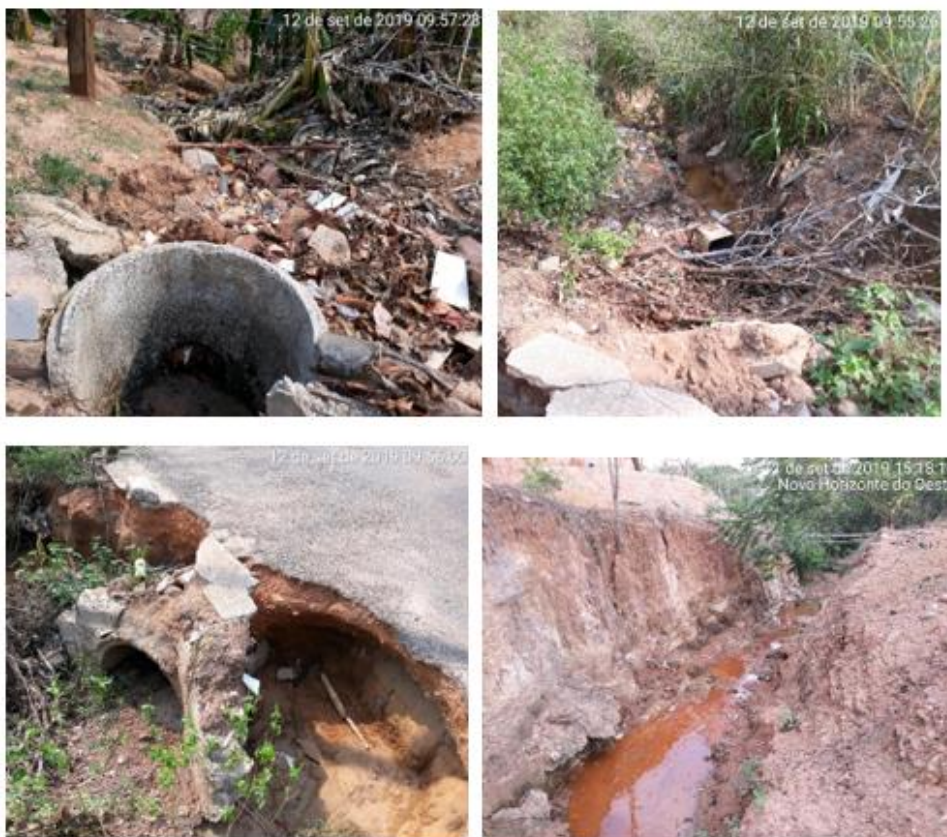
Figura 156 - Ausência dispositivos de lançamento adequado para águas de drenagem e indicação de processos erosivos
