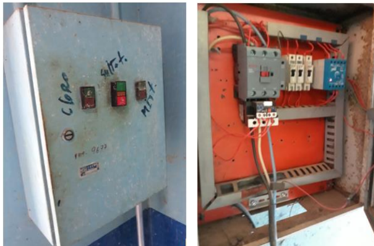
Figura 92 - Vista externa e interna do painel de comando.
