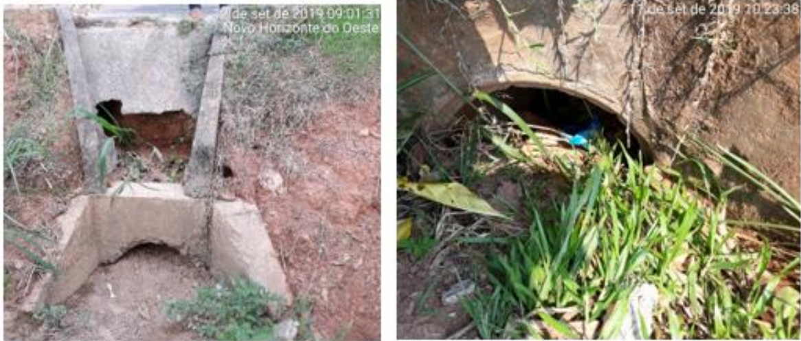
Figura 155 - Deficiência de manutenção para a desobstrução de galerias
