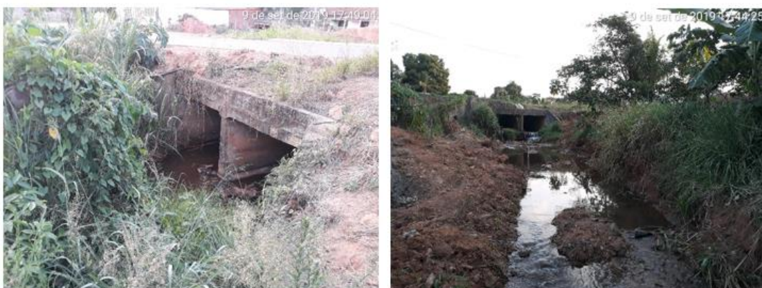
Figura 142 - Galeria e canal natural de escoamento de águas fluviais e pluviais – distrito de Migrantinópolis
