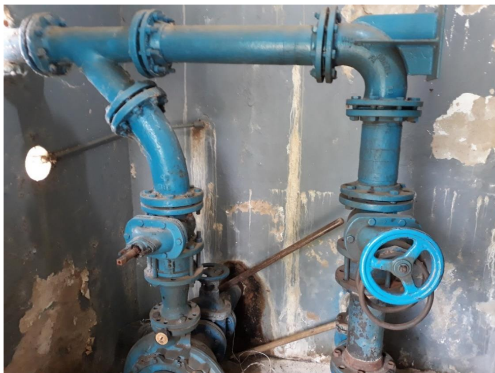
Figura 81 - Barrilete EEAT Novo Horizonte
