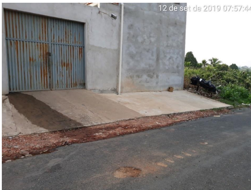
Figura 126 – Efluente saindo de pátio de supermercado Rua Amapá
