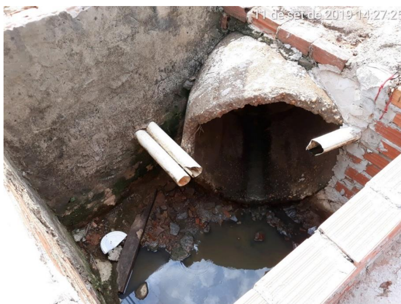
Figura 157 – Ligação clandestinas de esgotos boca de Lobo presente na Av. Carlos Gomes, Novo Horizonte do Oeste - Sede.
