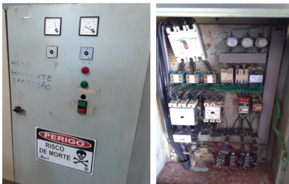
Figura 66 - Vista externa e Interna do painel de comando.
