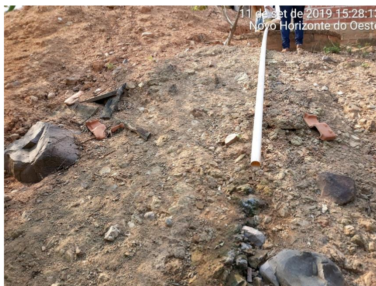
Figura 116 – Lançamento de esgotos de pia e chuveiro em canal de drenagem natural
