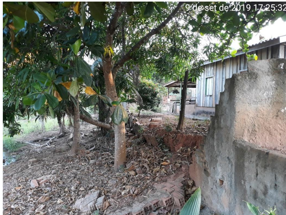
Figura 171 – Queda de muro provocada pelo represamento após a instalação dos tubos arcos
