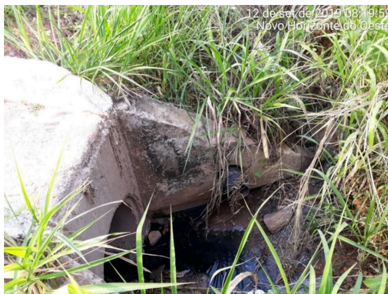
Figura 124 – Lançamento de esgotos em canal de drenagem Travessa Aparecida C. Rodrigues (sede)
