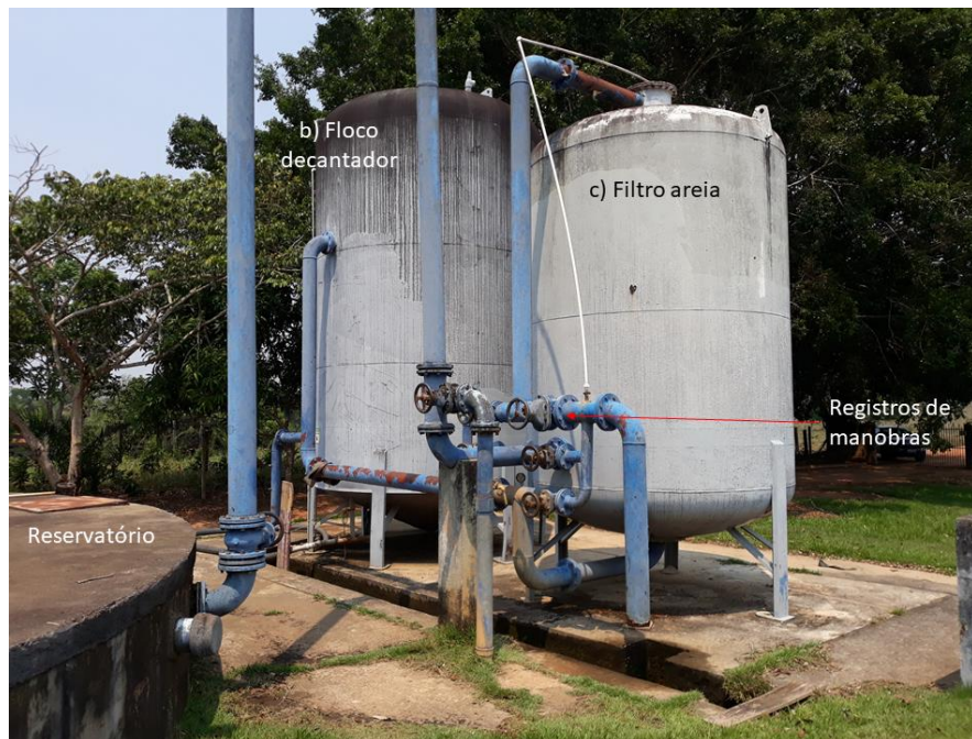
Figura 73 - Elementos que compõe a ETA Novo Horizonte do Oeste – Vista 2.
