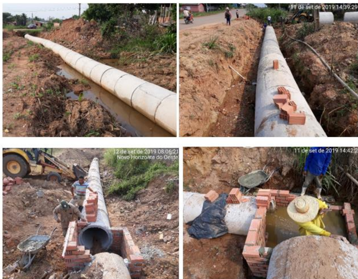
Figura 148 – Instalação de rede de microdrenagem e confecção de bocas de lobo (sede)
