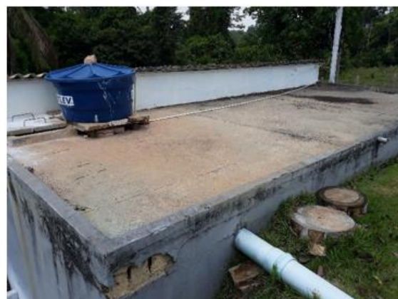
Figura 77– Caixa de preparo e dosagem do cloro no reservatório
