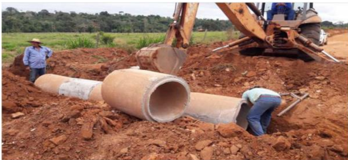
Figura 57 – Implantação de tubos de concreto (manilhas) na área rural do município.
