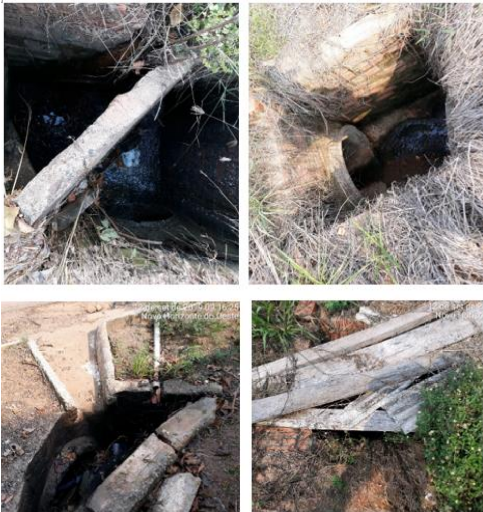
Figura 152 - Ausência de tampa para as bocas de lobo
