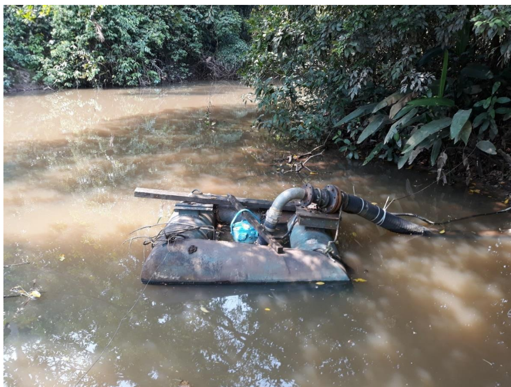
Figura 65 - Estação Elevatória de Água Bruta (EEAB) Novo Horizonte - Sede.
