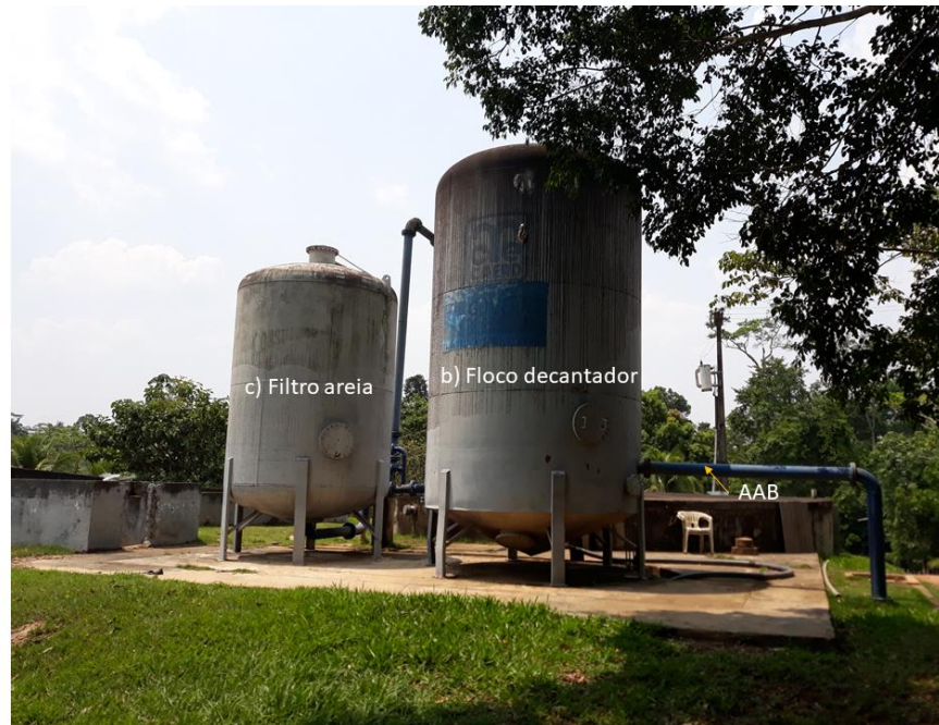
Figura 72 - Elementos que compõe a ETA Novo Horizonte do Oeste – Vista 1
