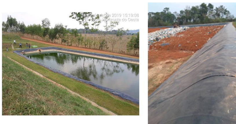
Figura 182 – Esquerda: Drenos de águas pluviais na célula. Direita: Manta de impermeabilização de base e laterais com manta de PEAD de 2,0 mm.
