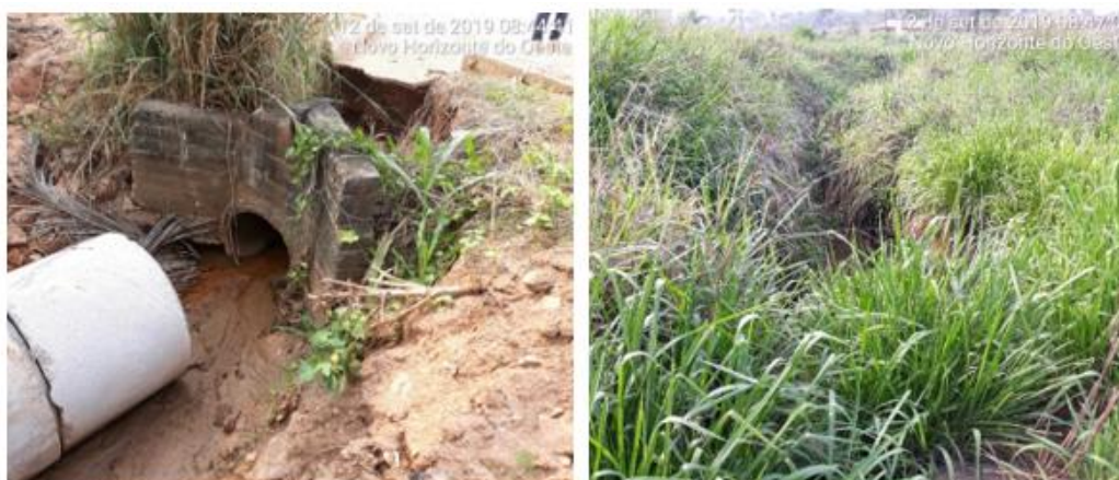
Figura 145 - Montante (esquerda) e jusante (direita) de galeria (600mm) para escoamento de águas de valas que cruzam a Rua Hermano Bento Serafim
