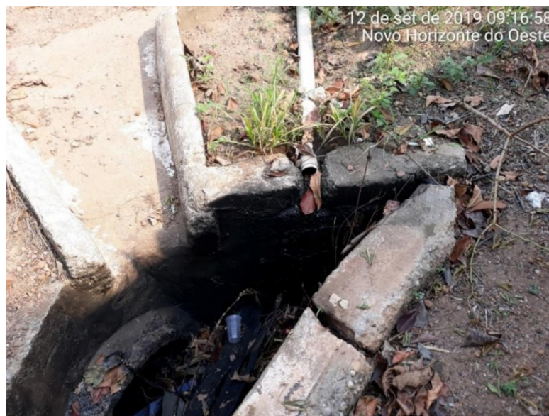
Figura 122 – Lançamento de esgotos em galeria pluvial Rua das Flores – sede
