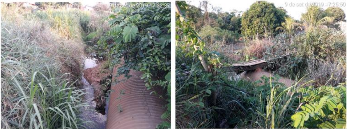
Figura 174 - Rompimento de aterro da macrodrenagem evidenciando a insuficiência para esgotamento, Av. Pinheiros
