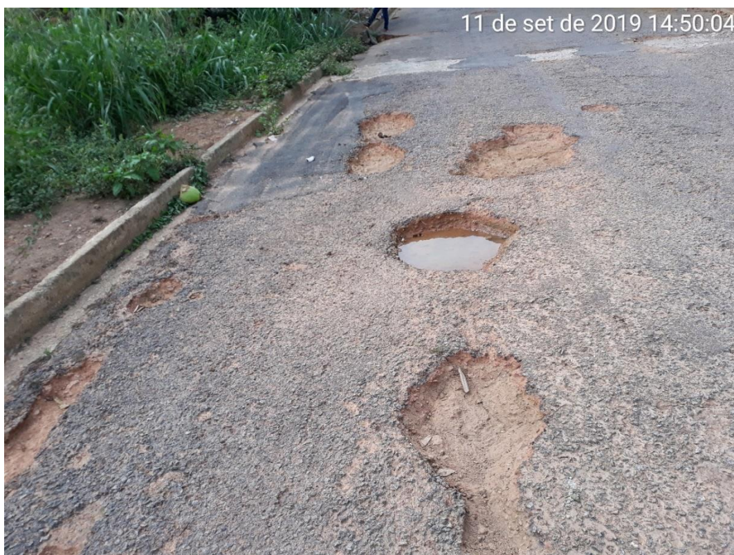
Figura 168 – Erosão no pavimento provocado por enxurradas (Rua Perobão - sede)
