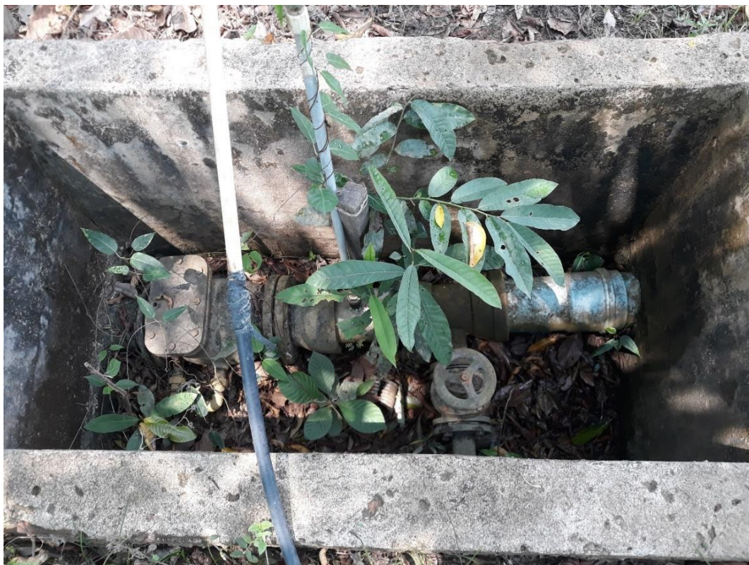
Figura 67 - Registro gaveta do sistema de adução de água bruta.
