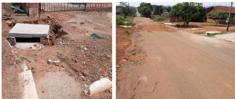
Figura 147 - Infraestrutura de drenagem na Av. 07 de setembro – apenas boca de lobo (Distrito de Migrantinópolis)
