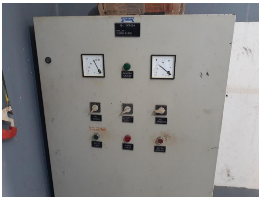
Figura 82 - Painel de comando EEAT.
