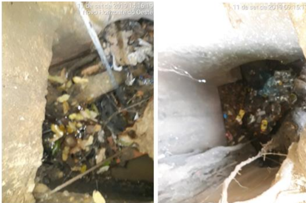
Figura 153 - Vista interna de boca de lobo com acúmulo de resíduos
