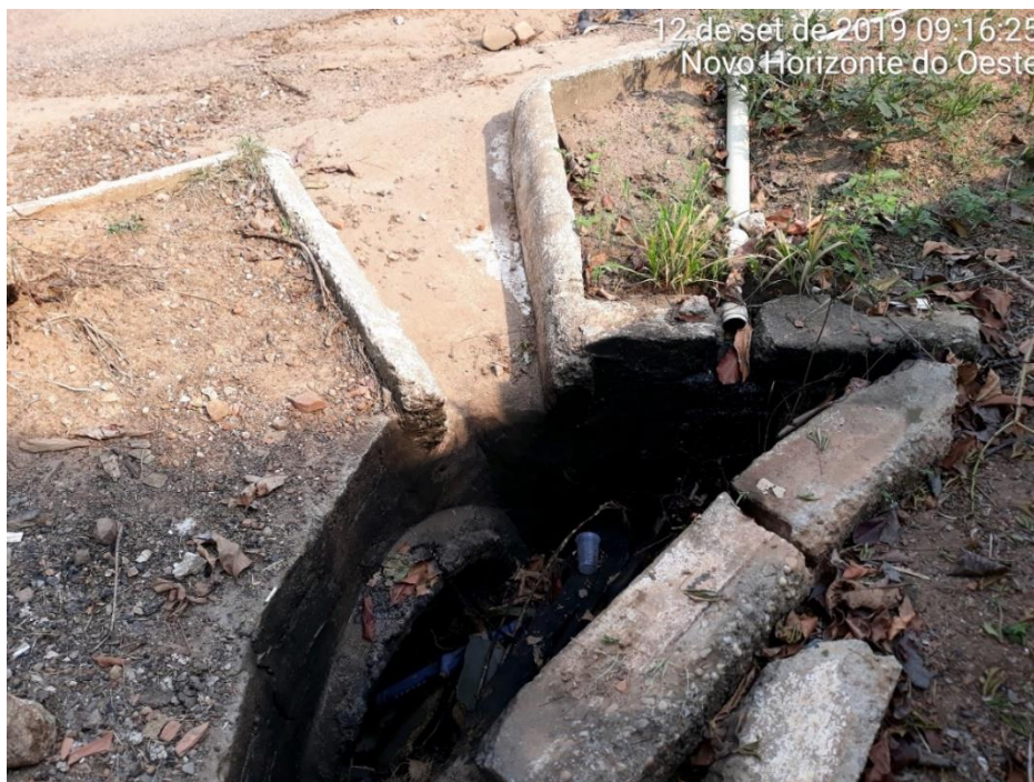
Figura 161 - Lançamento de esgotos em galeria pluvial Rua das Flores – sede
