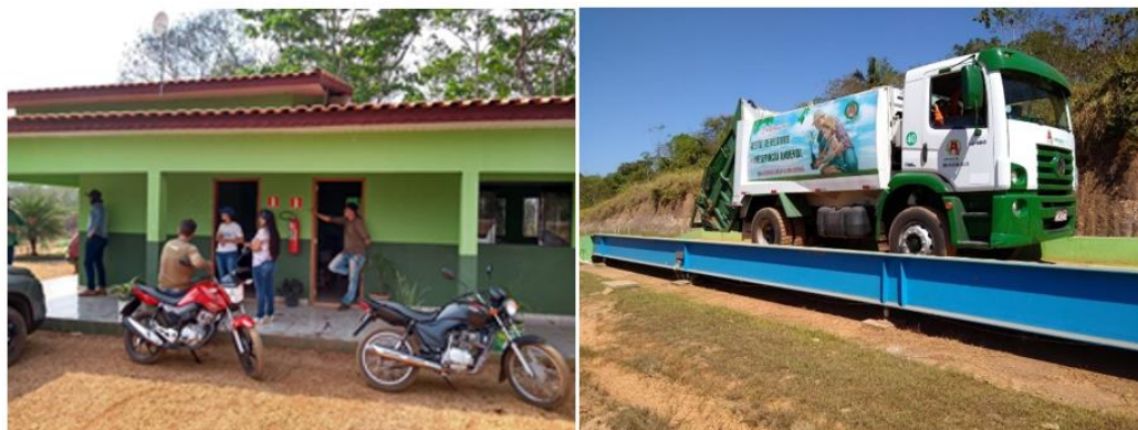
Figura 180 – Esquerda: Escritório administrativo. Direita: Balança rodoviária para pesagem de RSU.
