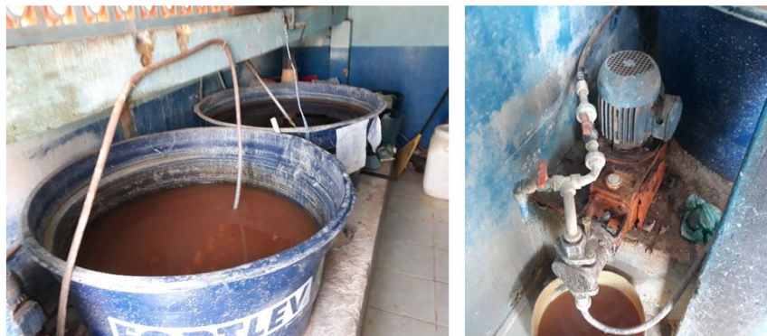
Figura 101 – Estrutura de Preparo do sulfato na ETA Novo Horizonte do Oeste Bomba dosadora de sulfato na ETA
