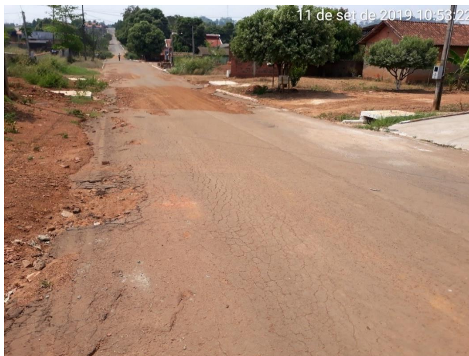
Figura 175 - Via danificada por águas de nascentes que afloram na localidade
