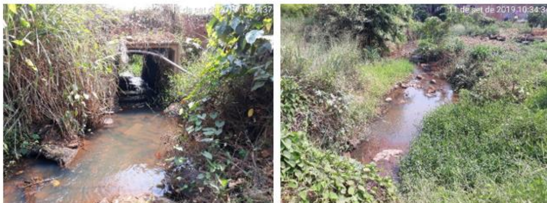
Figura 141 - Galeria simples de macrodrenagem na Av. 07 de setembro - Migrantinópolis
