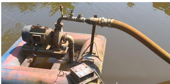
Figura 94 - Válvula de retenção e acoplamento da adução
