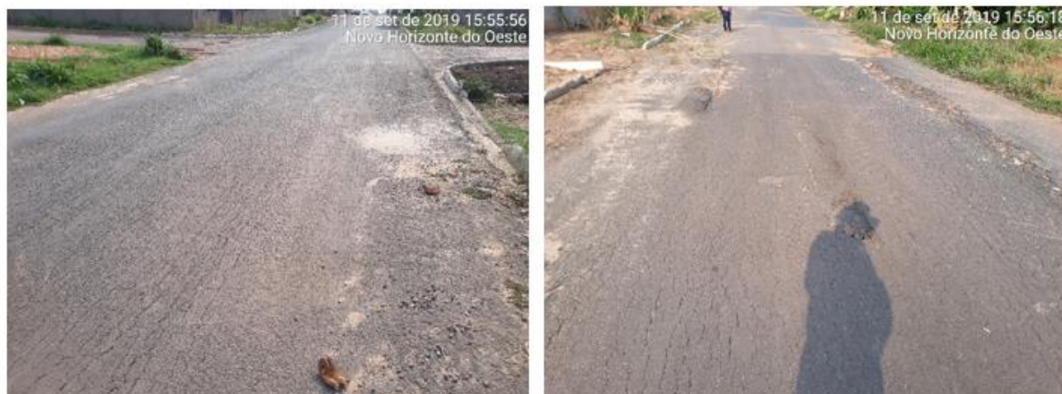
Figura 167 - Pavimento danificado pela ausência de drenagem de águas fluviais
