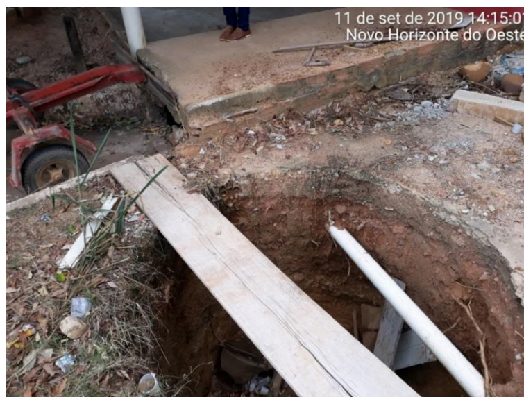
Figura 118 – Tubo de esgoto ligado diretamente em boca de lobo Rua Amapá (sede).
