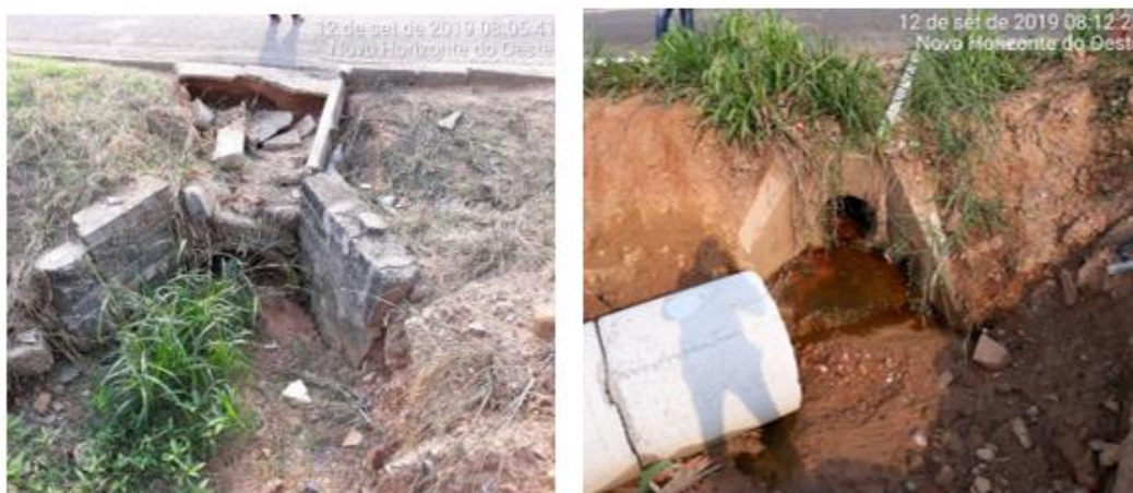
Figura 144 - Montante (esquerda) e jusante (direita) de pequena galeria (400mm) para escoamento de águas de valas que cruzam a Rua Amapá
